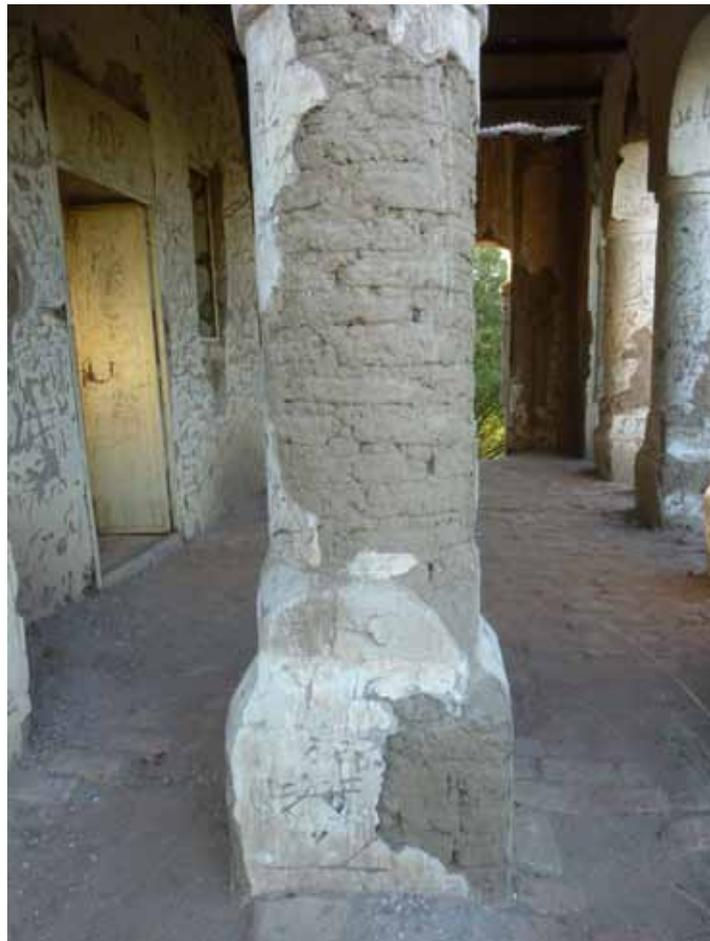
Fig. 15. Colonne de brique crue, palais de la famille des *Melik* sur l'île d'Argo (© Mission Kerma-Doukki Gel/S. Marchi)
